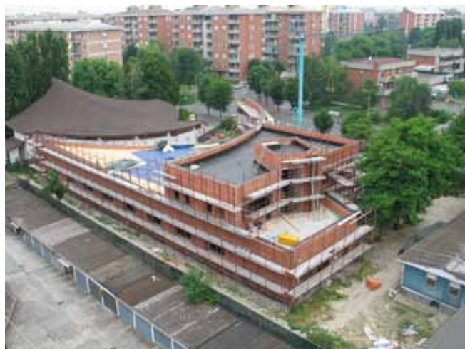
Vista aerea da sud
